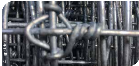
Abb 26 Zaun mit aufgesetzten und nicht-verschiebbaren Knoten
